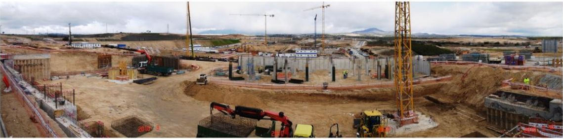
Vista general 1.000 VPP-AOCJ desde la 1.2A
